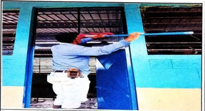
Foto 4: Vista del proceso de lijado, cepillado, pintado de puertas del edificio escolar.
