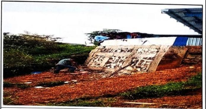
Foto 6: Vista del proceso de la rehabilitación del muro, parte de Centro Educativa por los constantes deslizamientos de tierra.
